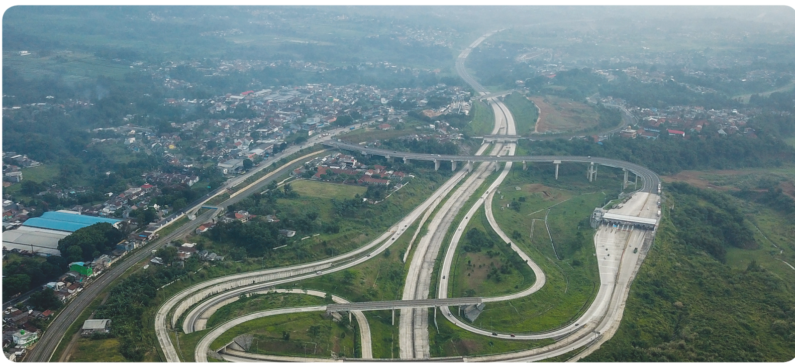
PROYEK JALAN TOL BOCIMI
